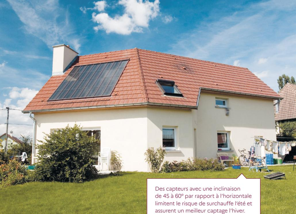
Des capteurs avec une inclinaison de 45 à 60° par rapport à l'horizontale limitent le risque de surchauffe l'été et assurent un meilleur captage l'hiver.
