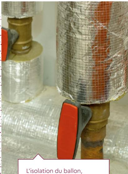
L'isolation du ballon, comme de la tuyauterie (le calorifugeage), est vivement conseillée dans les locaux non chauffés (cave, garage).
