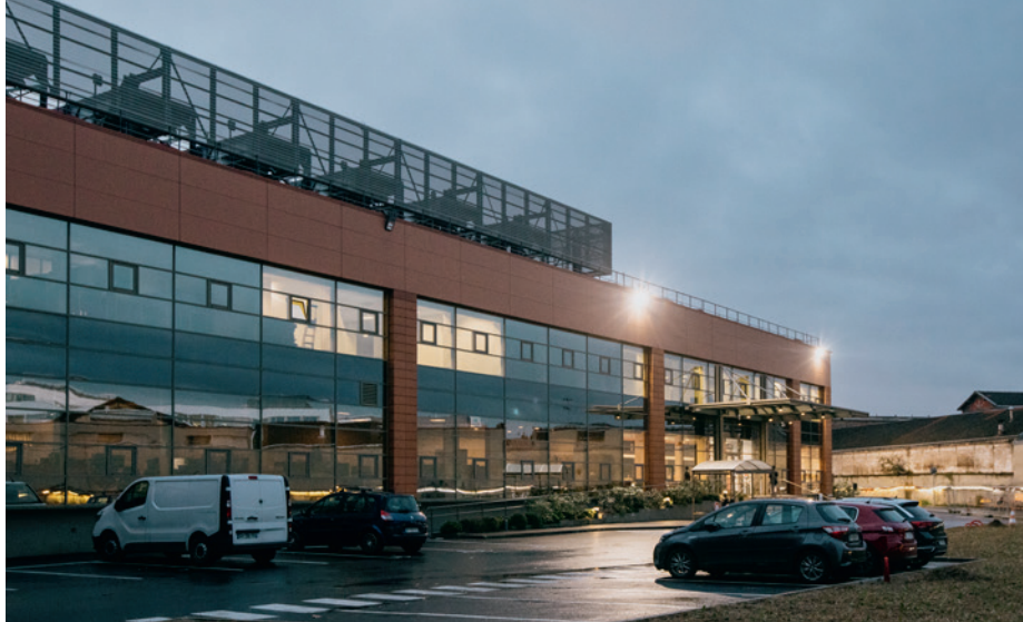
Vue sur le campus de data center d'Equinix, à Saint-Denis (93).
