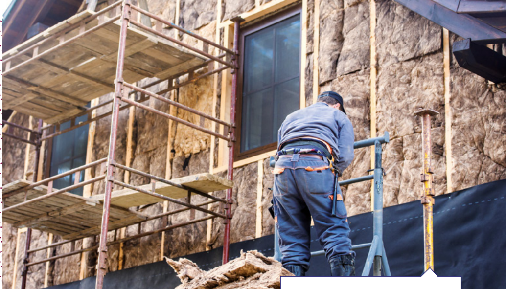
Isolation par l'extérieur en panneaux de laine de verre.
