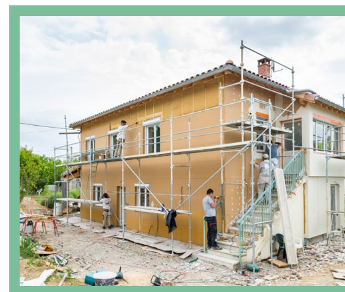
Rénover les bâtiments
