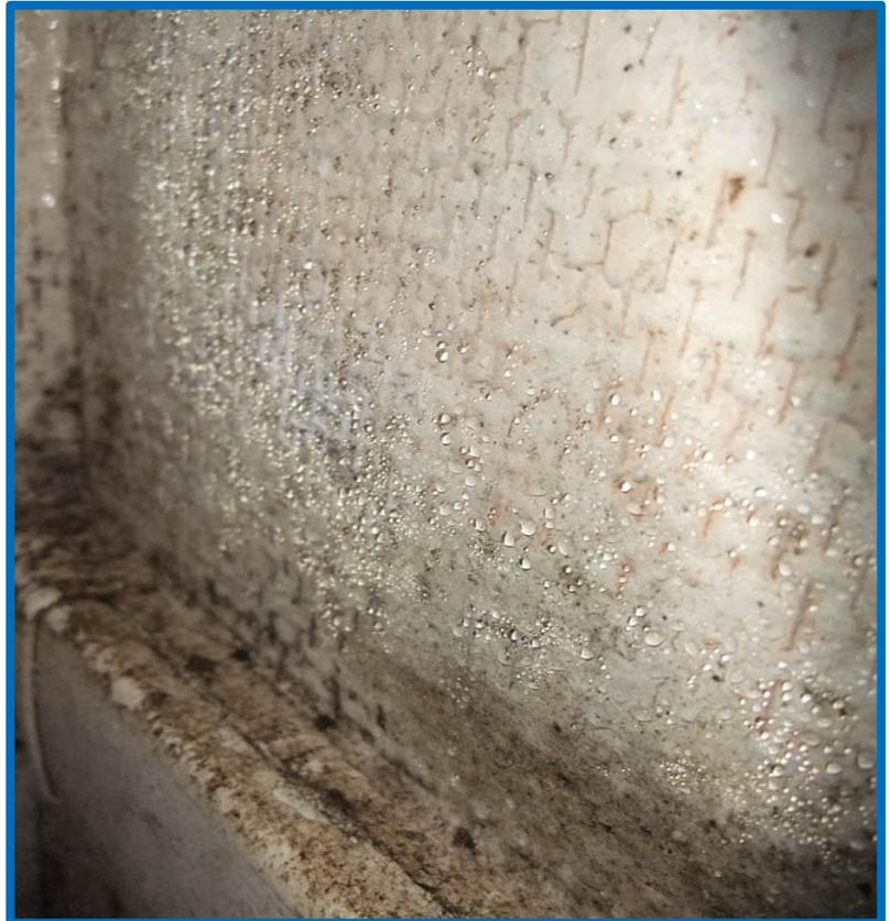
Condensation d'air chaud et humide sur une paroi froide dans une chambre quotidiennement aérée
