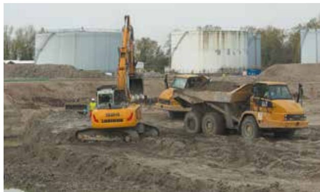
Travaux d'excavation des terres sur un site industriel à Strasbourg en vue de sa dépollution « hors site ».
