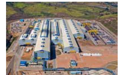
Usine de Vallourec
