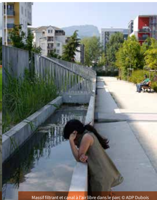
Massif filtrant et canal à l'air libre dans le parc © ADP Dubois
