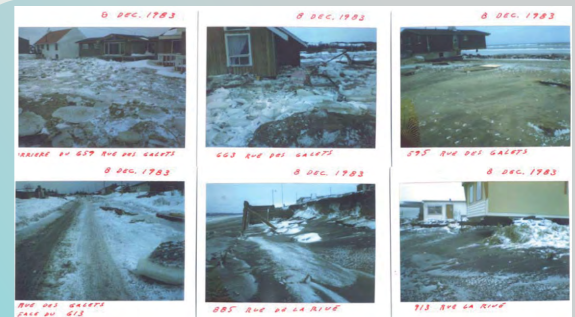
Figure 68 : Dommages de la tempête des 7 et 8 décembre 1983 dans la région de Sept-Îles - UQAR (2008).
