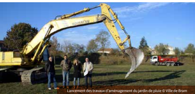
Lancement des travaux d'aménagement du jardin de pluie © Ville de Bram
